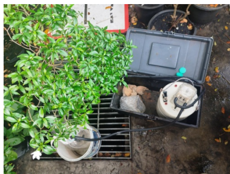
ภาพที่ 3-19 บ่อตรวจคุณภาพน้ำฝาดะแกรงเหล็ก และภายในมีตะแกรงดักขยะ
