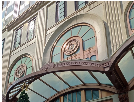
ภาพที่ 3-2 ใช้กระจกที่มีค่าการสะท้อนแสงไม่เกินร้อยละ30"
