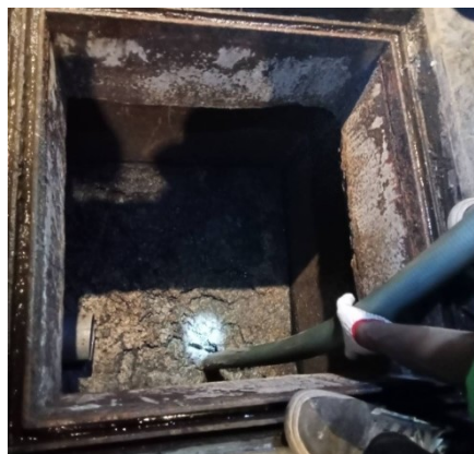
ภาพที่ 3-41 ดูแลซ่อมบำรุงระบบบำบัดน้ำเสียและสูบน้ำที่บ่อพักตะกอน
